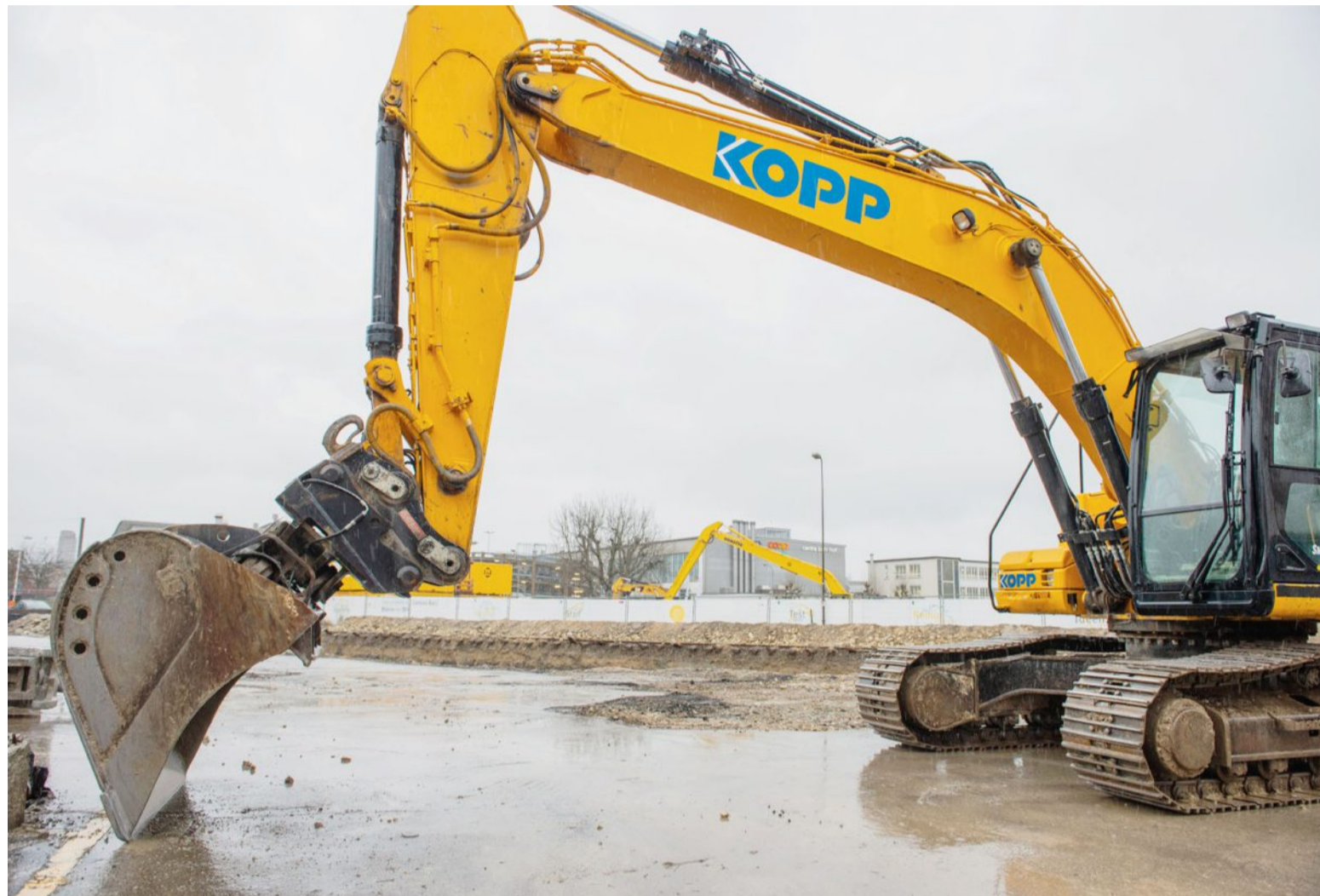
Auf der Baustelle des Innovationsparks haben die ersten Arbeiten für den Neubau begonnen.
